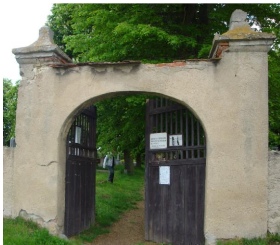
Oprava zdí dokončena Zbývá úprava vstupů k oběma hřbitovům
